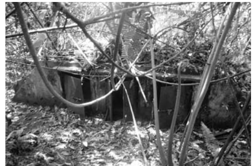
図24 レンゲル島の山の西部中腹にある、150mm砲座脇の砲側弾薬庫
