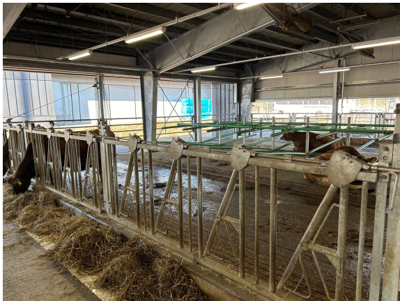
乳牛1頭当たりのスペースを十分に確保したフリーストール牛舎。ストール枠の素材は特殊PVCで、牛の怪我リスクが低減。
