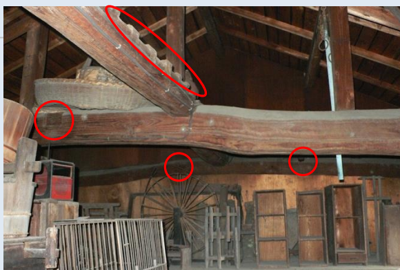
神奈川県茅ヶ崎市内の長屋門の小屋組(明治中期)。○は痕跡。梁材の8割が古材利用。
